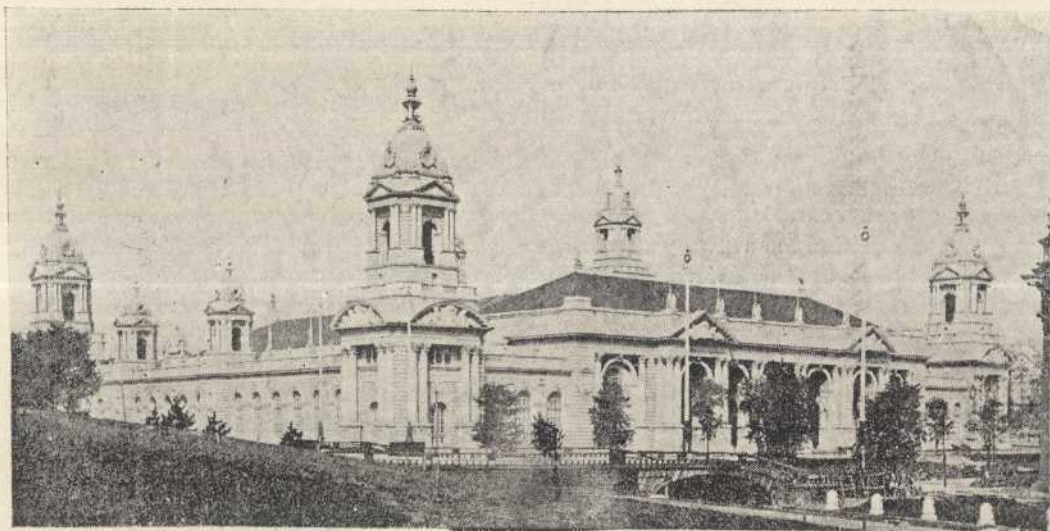
PALACIO DE LA ELECTRICIDAD
